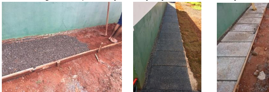
Figura 2: Calçada com placas de piso permeável, em três etapas
