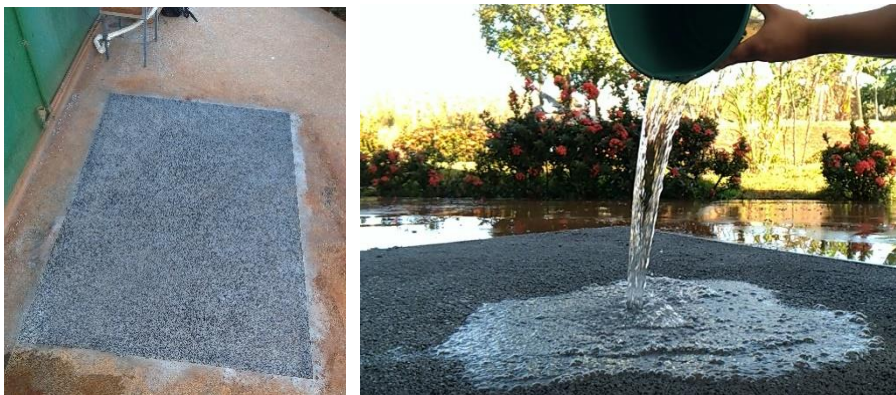
Figura 5: Piso permeável do bebedouro e ilustração da permeabilidade.
