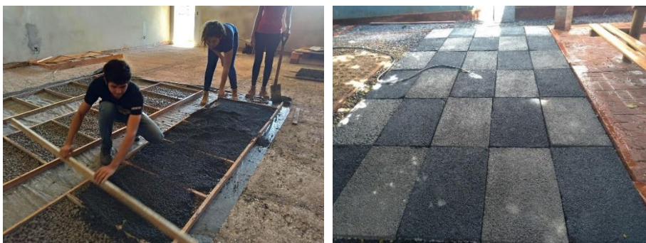
Figura 3: Construção e assentamento das placas de concreto permeável
